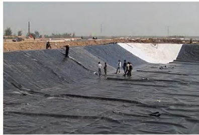
Geomembrane bonding
